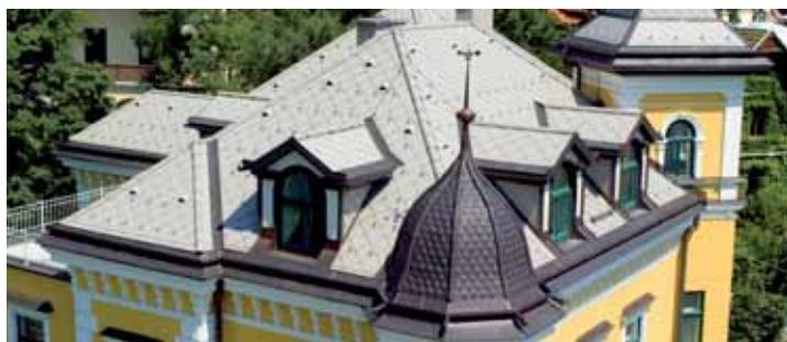
Renoviertes Villendach im Salzkammergut (Eternit Dachschindel und Kupfer)
