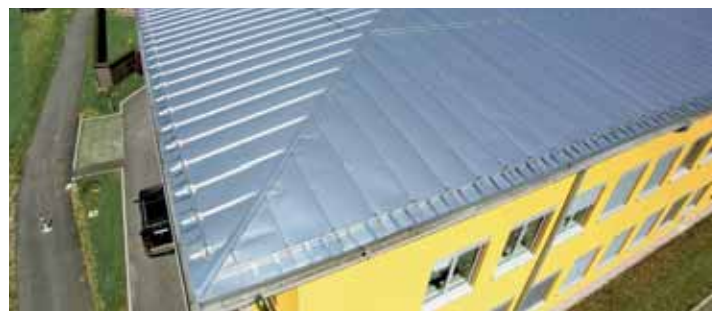
Neubau Technologiezentrum inneres Salzkammergut (Bandblech Alu beschichtet)
