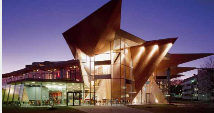
Von KTP Architekten mit Allplan geplant: Das neue Mitarbeiterrestaurant von Boehringer Ingelheim Pharma KG
